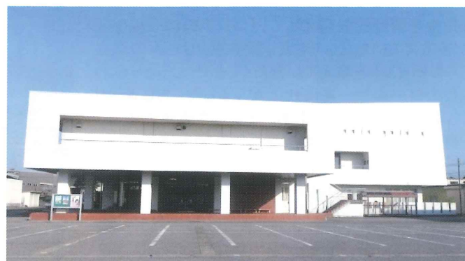
昭和54年の竣工から40年が経った 高月まちづくりセンター(旧高月公民館)
