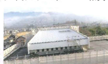
大屋根改修完了
