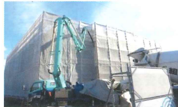
現在のまちセン外観と生コンポンプ打設
